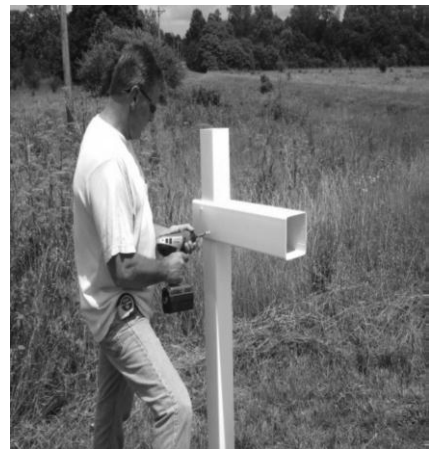
STEP 6 SECURE ARM Brazo de forma segura
